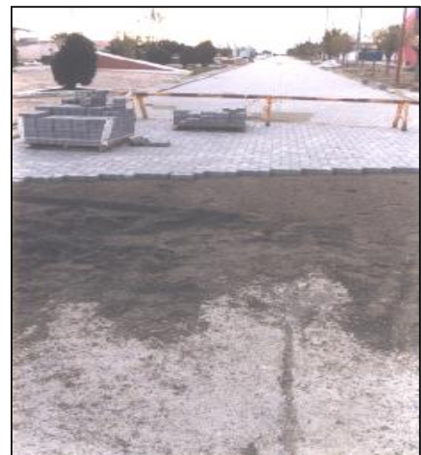
Esparcido de la arena de asiento y colocación de adoquines
