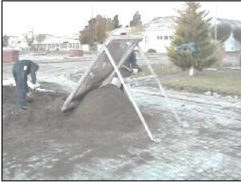
Tamizado y secado de arena para sello
