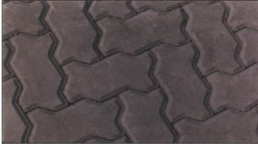
Figura 2: Adoquín modelo “unistone” – Patrón “espina de pescado”
