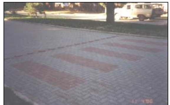
Sendas peatonales y reductor de velocidad con adoquines de colores
