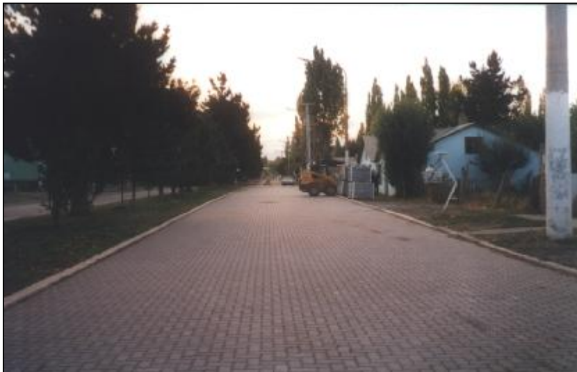
Vista general de un tramo terminado.
