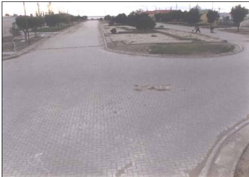
Aspecto de un tramo terminado
