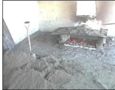
Tamizado y secado de arena para sello
