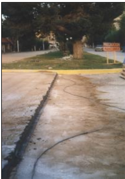
Confinamiento metálico. Perfil angular anclado al pavimento.
